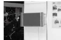
32インチ液晶モニター 壁面取付
