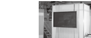
60インチ液晶モニター 壁面取付
